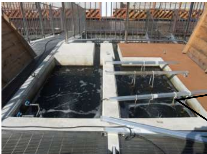
写真 3.2 懸濁物除去水槽(右側)および曝気水槽(左側)
