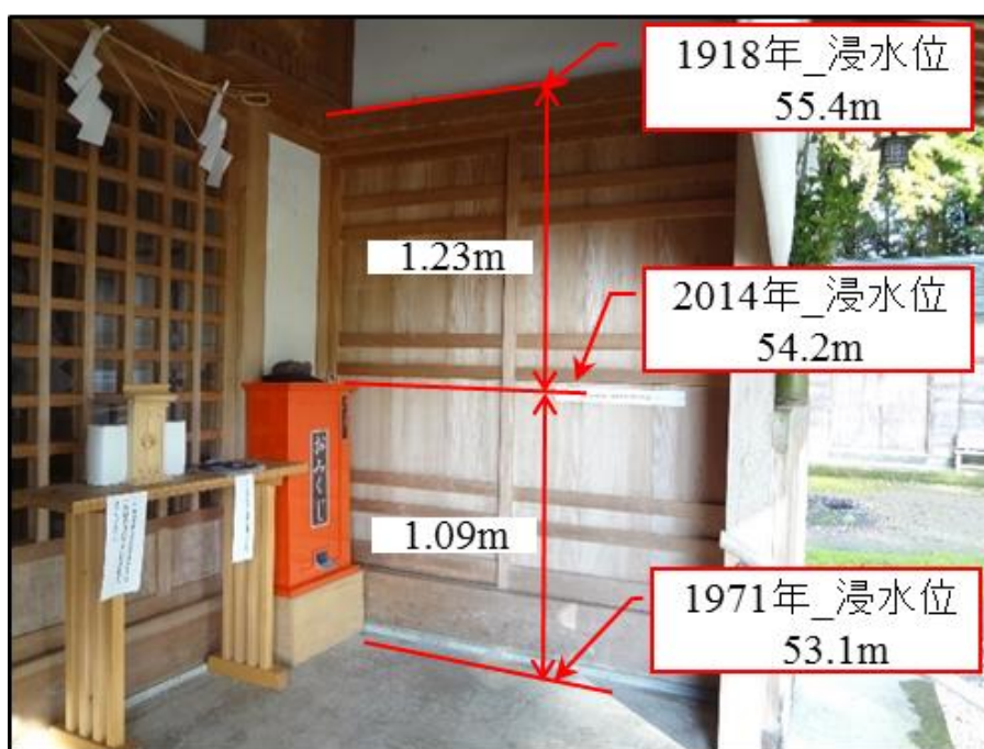
図 3-9 蛭子神社本殿（上段：全景，下段：内側の壁面）
