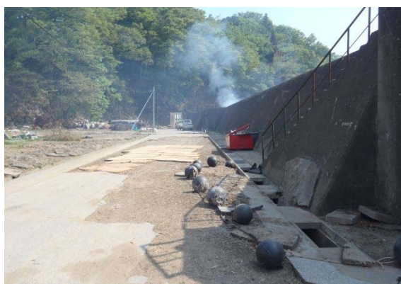
写真 2.11 広田漁港海岸における陸閘(護岸陸側より撮影)
