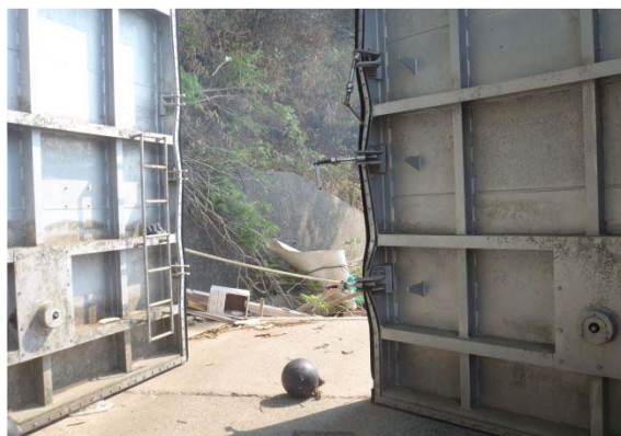
写真 2.10 広田漁港海岸における陸閘(護岸陸側より撮影)
