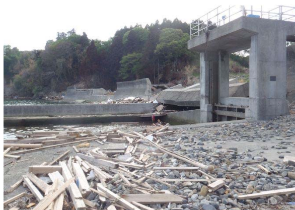
写真 2.9 脇之沢漁港海岸(護岸海側より撮影)
