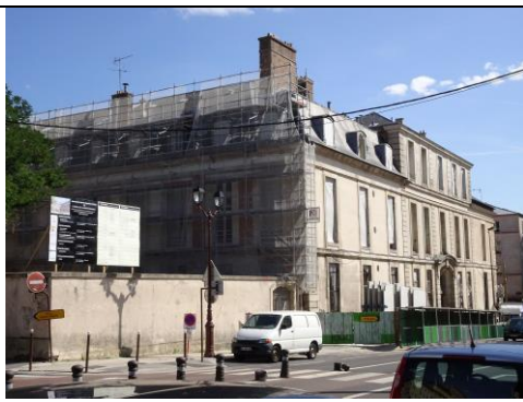
【図2】総監公邸(ヴェルサイユ) ヴェルサイユ宮殿から一本通りを挟んだ場所にあ る。現在は集合住宅への改装工事が進行中。 [写真:筆者撮影(2017年8月)]
