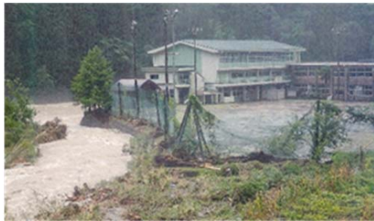
写真-1 B中学校の浸水時の状況 (B中学校提供)
