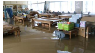
写真-3 校舎2階の浸水状況
