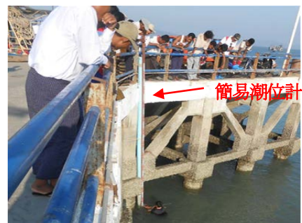
写真-1 簡易潮位計の現地設置講習状況
