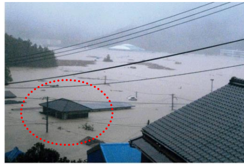
写真-1 2011年紀伊半島豪雨で2階建のB施設が水没している様子（B施設より提供）
