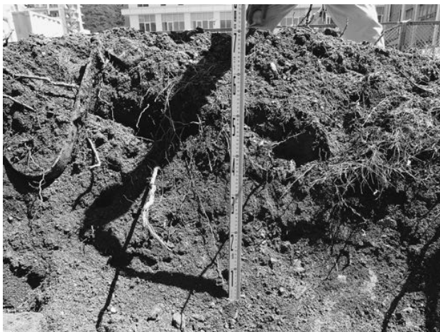
図4 (蔵本) 外来診療棟新営その他工事
