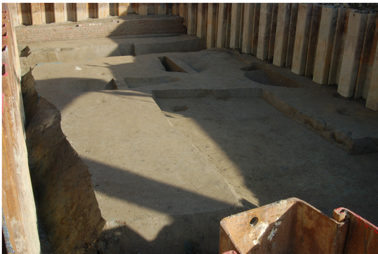
図 3-9 第 1 遺構面の完掘状況（西から）
