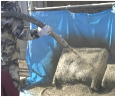
木製型枠吹付け
