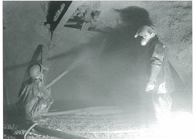
トンネル壁面を安定させる吹付けコンクリート施工。海底トンネルの掘削面を早期に安定させるため、青函トンネルではより早強性の高い工法・材料が必要とされた（昭和45年3月）
