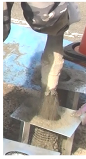
金網円筒型枠 吹付け
