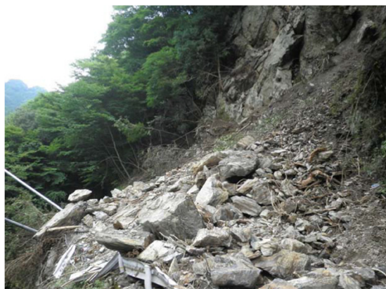
斜面崩壊状況
