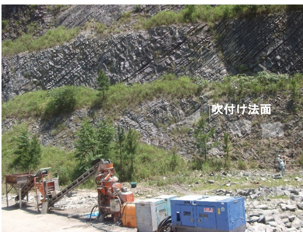
写真 5.4 プラントおよび吹付け法面
