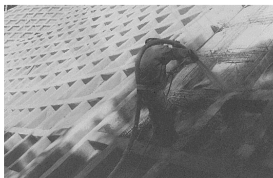
写真 1.7 法面吹付け作業 (吹付け砕工)
