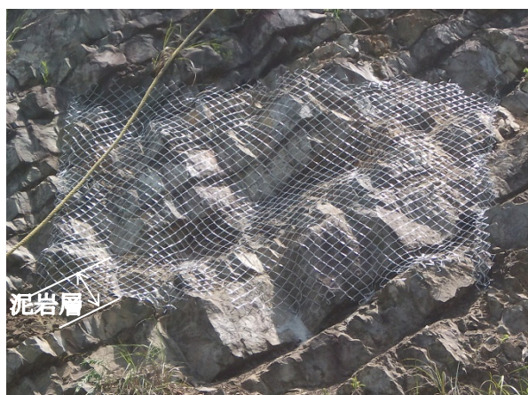
写真 5.3 ラス金網設置(縦 2.0×横 2.5m)
