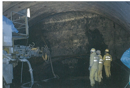
写真 1.6 トンネル吹付けコンクリート工（吹付けロボット） 17)
