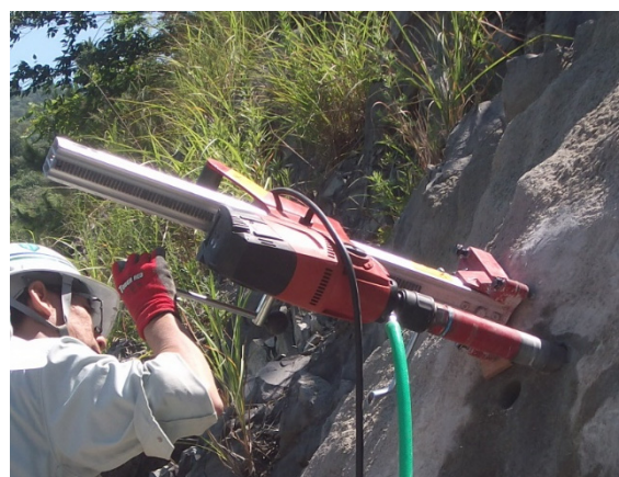
写真 5.7 圧縮強度試験用供試体切出し・接着強度試験用φ50mm切込み
