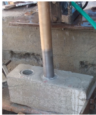
写真 4.9 接着強度試験後の 圧縮強度試験用コア供試体切出し
