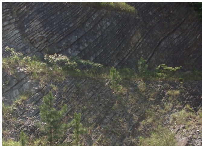
写真 5.1 試験施工法面
