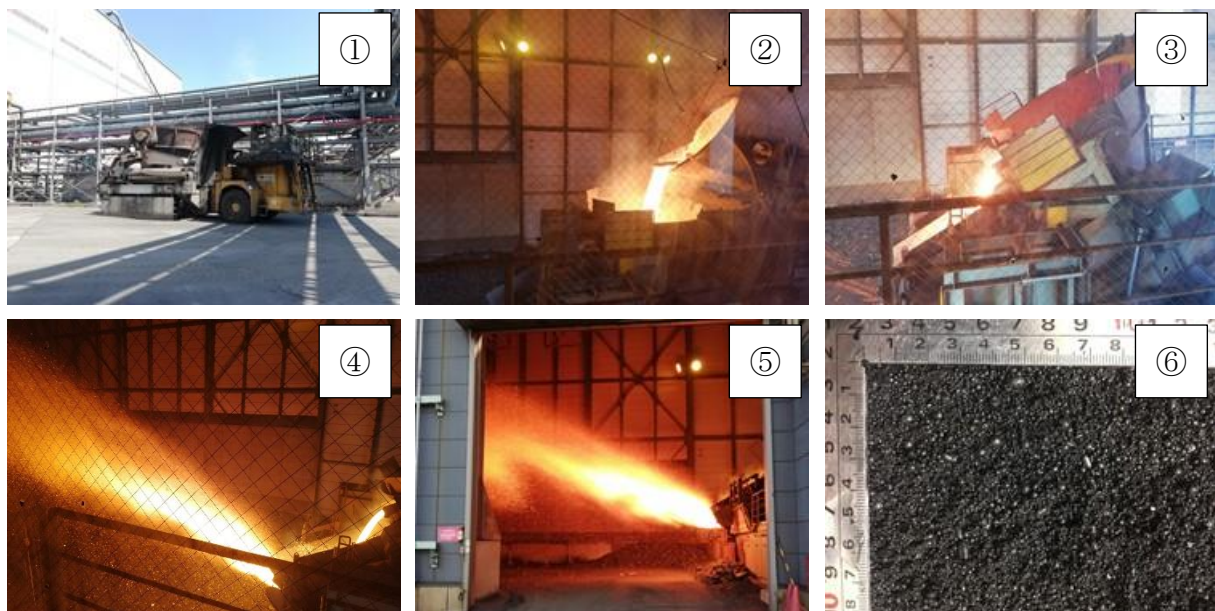
写真 3.1 電気炉酸化スラグの製造状況および外観形状
