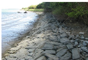
St.5 空石張り(北向き)
