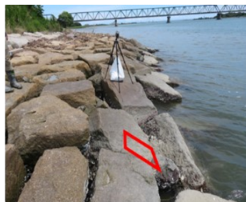
St.1 巨石張り (南向き)
