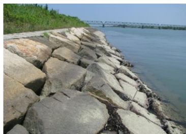
St.1 巨石張り(南向き)
