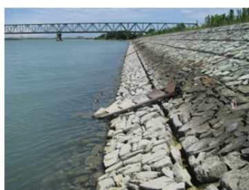
St.4 環境保全型ブロック (北向き)
