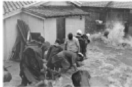
写真-4 崩れた護岸に土のうを築く徳島東消防署員と地元の消防団員たち、（図-5-⑪）、（徳島新聞社提供）
