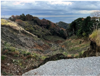
(b) 源頭部右岸側崩壊の状況
