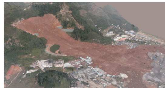
(b) 崩壊後の状況
