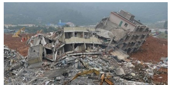
(c) 倒壊したコンクリート建物
