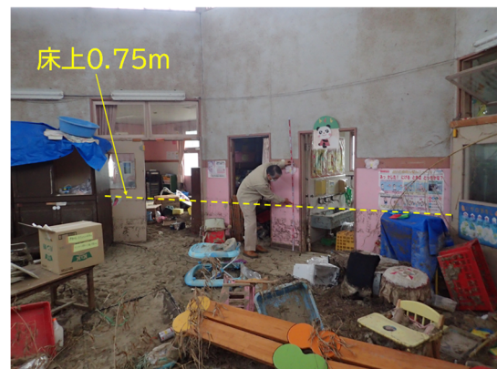
写真-2 U3 保育園の被害状況 (2018年11月8日に著者撮影した写真に浸水ラインを加筆)
