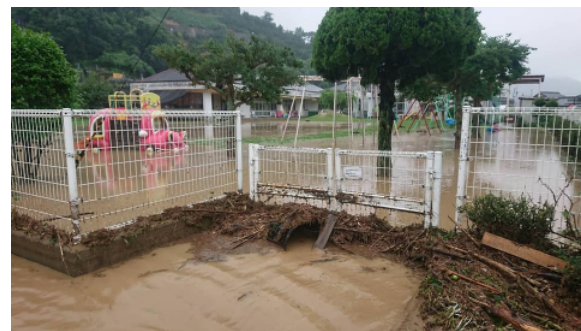
写真-3 U4保育園の土砂流入被害 (宇和島市提供)
