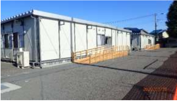
写真-3 施設 A の福祉仮設住宅
