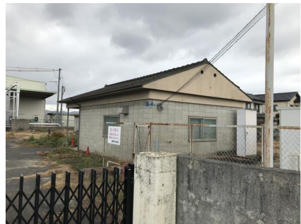
写真-3 被災した真備浄水場
