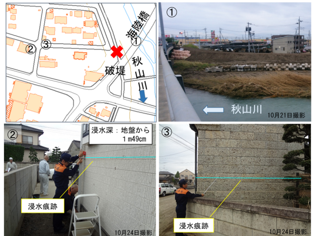
図-4 秋山川・海陸橋上流右岸の決壊箇所付近の被害
