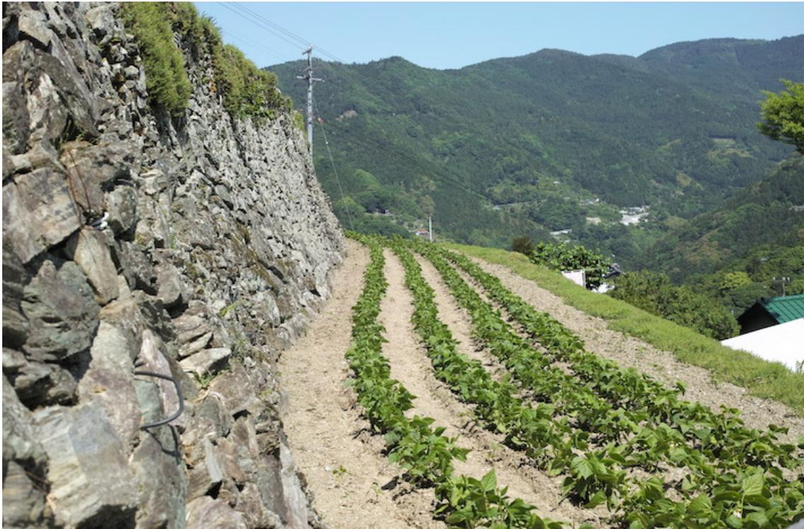
図 2-4 空石積みの構造物(農地の造成)
