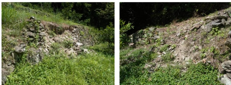
図 2-12 大神集落の石積みの崩壊の様子 <sup>37</sup>
