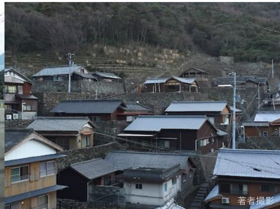
図 2-3 空石積みの構造物(擁壁)
