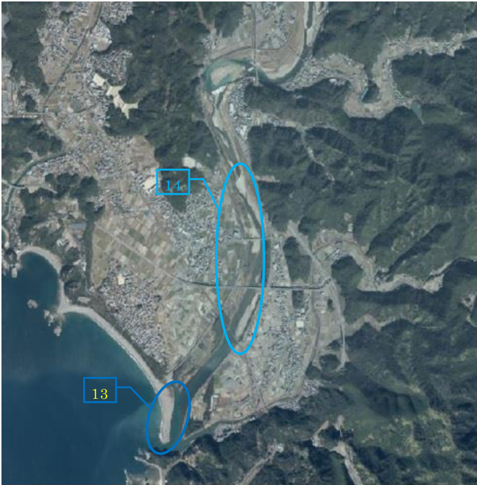
写真 2-14 富田川流域航空写真 5 2020（令和 2）年撮影
