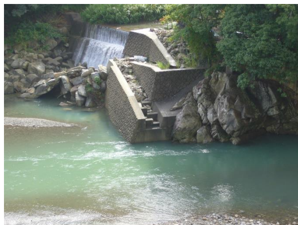
写真 2-3 富田川と西谷川の合流点の魚道
