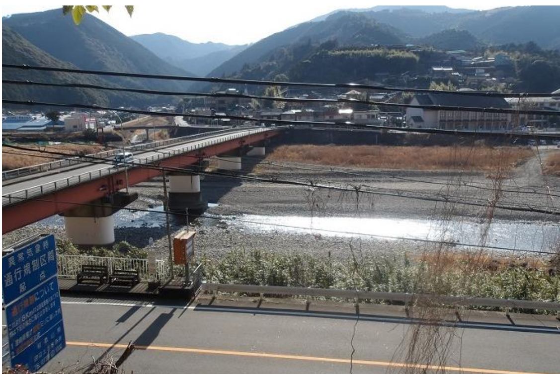
写真 2-9 富田川 旧大塔村鮎川 鮎川新橋 2022(令和 4)年 2 月 2 日撮影
