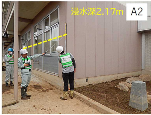
図-2 A小学校の浸水状況 (2019年10月21日撮影)
