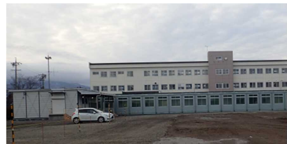
写真-2 校庭に建てられた仮設校舎 (A小学校, 2020年1月18日撮影)
