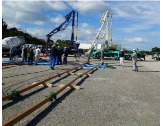
写真-2 2系列による圧送配管
