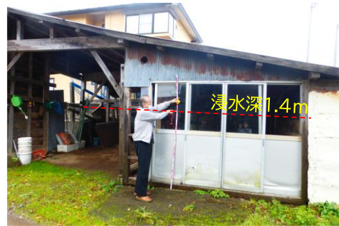
写真-4 高齢者施設②の浸水痕跡（浸水深 0.9m）と近くの民家の浸水痕跡（浸水深 1.4m）
