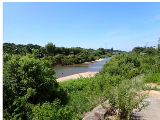
写真-1 馬場目川右岸（○地点）から下流側の植生繁茂の状況（2023年8月6日撮影）
