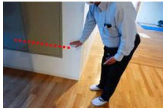
図-6 施設Bの浸水状況（屋内）
